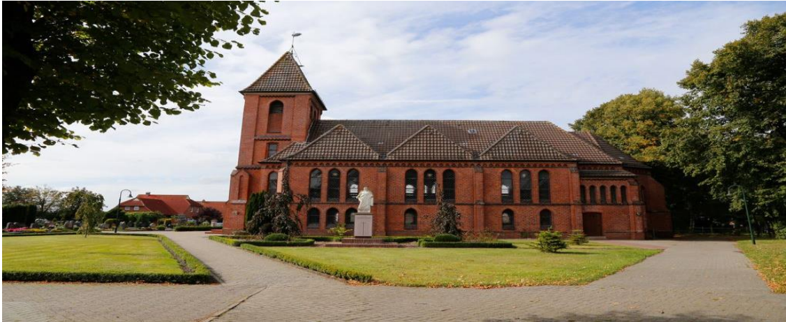
Foto: Ev.-luth. Kirche Münkeboe-Moorhusen 35
