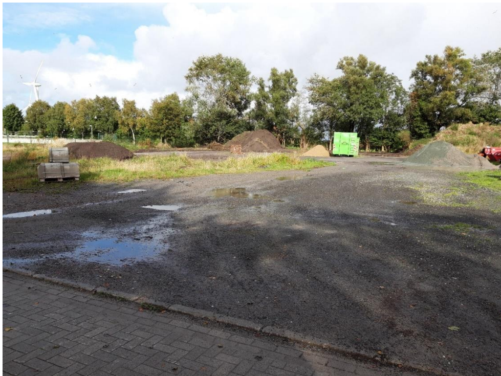
Abb. 5: Geplanter Standort für den Neubau der Klinikkläranlage, Blick aus südwestlicher Richtung (Foto: BioConsult)
