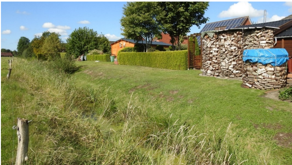
Abb. 12: Gewässer Nr. 4 – Abschnitt des Uthwerdumer Vorfluters südlich der Wohnsiedlung, niedriger Wasserstand, hoher Verlandungsgrad im Spätsommer (02.09.2020)
